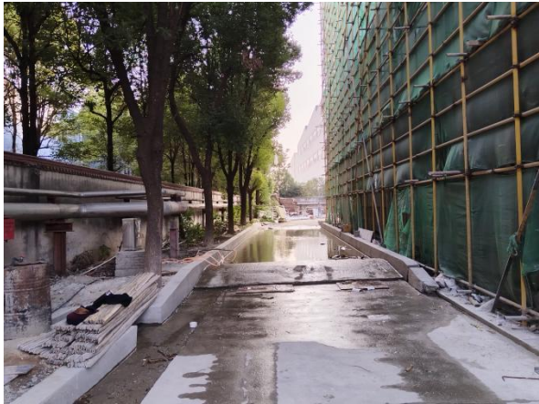
项目车辆冲洗设施现状（拍摄时间2024年11月）
