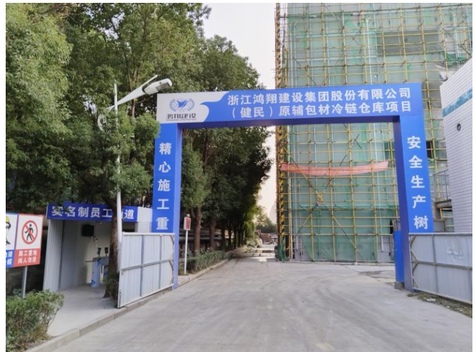
项目地块北侧入口处现状（拍摄时间2024年11月）
