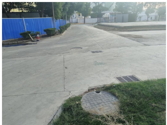
项目区周边健民原厂区排水现状（拍摄时间2024年11月）
